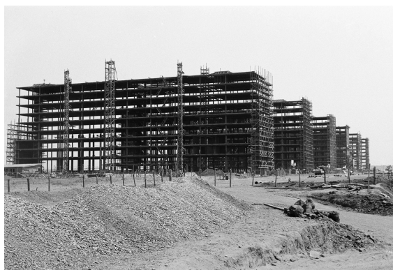
Brasília, construção dos edifícios ministeriais. A nova capital, inaugurada em 21 de abril de 1960, impulsionava a interiorização brasileira e diminuía a capacidade de pressão popular sobre o governo nacional.
